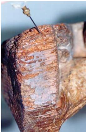
Detalle del proceso de consolidación de la madera debilitada por la acción biológica
