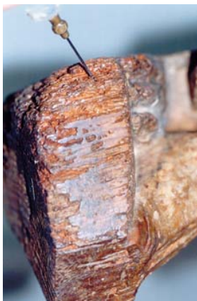
Detalle del proceso de consolidación de la madera debilitada por la acción biológica
